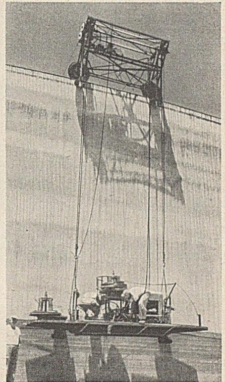
Abb. 4. Wickelmaschine.
