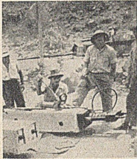
Abb. 3. Aufbringen der Vorspannung mittels einer hydraulischen 50-t-Pressen.
