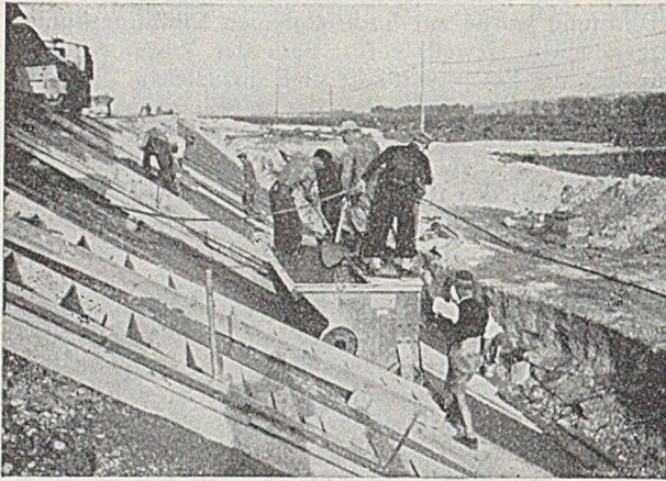
Abb. 7. Spezialeinbauanlage für Böschungsbeton.
