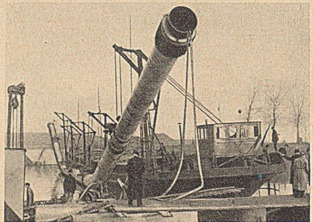
Abb. 28. Absenken der rd. 100 m langen östlichen Rohrleitung von 1,20 m  $\varnothing$  des neuen Pausmühlenbachdükers rd. 14 m unter den Wasserspiegel der Haltung III—IV vom 80 m-Kahn aus.
