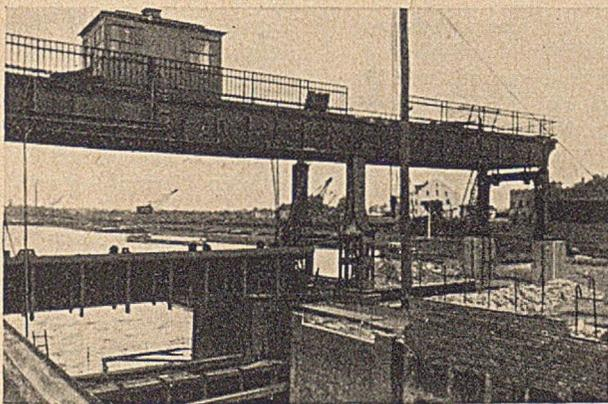
Abb. 17. Um 2 m gehobene Schiebetorbrücke mit abgehobenem Oberteil des Schiebetores am Unterhaupt der Südschleuse V.
