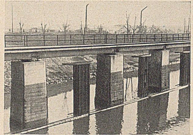
Abb. 22. Vorleitwerk aus Zwischendalben (Peiner P. Sp. 50 S).
