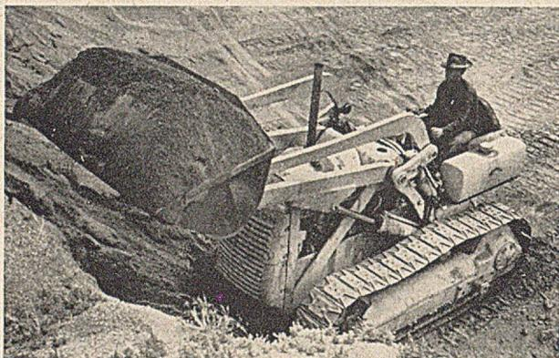
Abb. 3. Hydraulisch betätigter Traxcavator (Model HT 4) beim Abtragen und Verladen von Erde und Sand (Kübelinhalt 1 m<sup>3</sup>).
