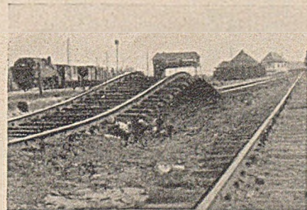
Abb. 5. Gleisstauchung (-verwerfung) infolge Preßwirkungen.
