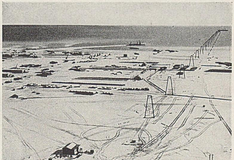
Abb. 1. Luftbildaufnahme über die Gesamtstrecke (rd. 5 km) der Kabelkran-Drahtseilbahn mit 24 Stützen zwischen der arabischen Wüste bei Ras el Misha'ab und dem im Persischen Golf neu gebauten Verladepier. — Im Vordergrund kleines Baubüro der Lieferfirma mit Reserveteilschuppen; am Strande Baustoffe für die zu bauende Ölleitung.
