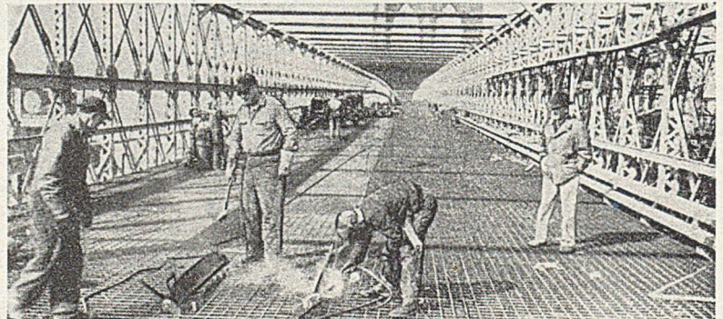
Abb. 25. Brooklyn-Brücke; Verlegen der USS-I-Trägerroste von 76 mm Höhe.
