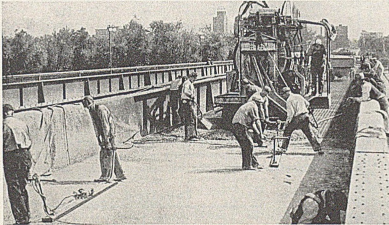
Abb. 19. Market Street Brücke in Harrisburg, Pa. Herstellung der Betonfüllung mit schweren Geräten.
