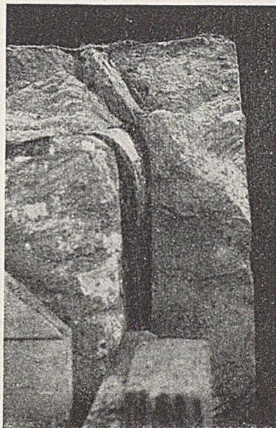
Abb. 8. Es ist deutlich zu sehen, wie die Isolierung, in diesem Fall weniger durch Schwinden als durch Wandern der Schutzschicht, vollständig von der Wand abgedrückt wurde
