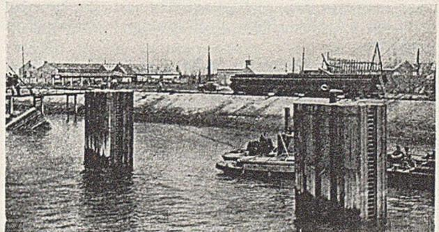
Abb. 6. Kastendalben in Zeebrugge, die sich bei Überlastung schiefl stellen.
