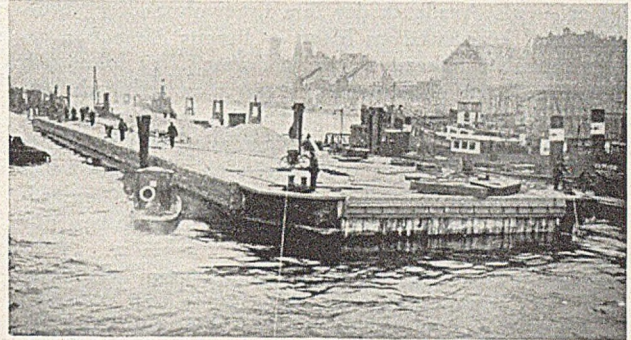
Abb. 12. Einschwimmen eines 90 m · 17 m großen Stahlbetonpontons der Überseebrücke (vgl. auch Abb. 10).
