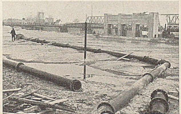
Abb. 22. Herstellung des Straßendamms über dem Siel.
