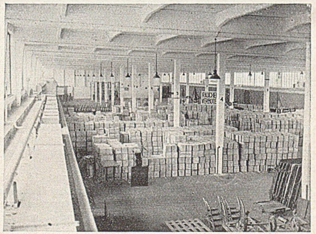
Abb. 9. Fruchtschuppen 34, Stahlbetonbauweise, doppelt verglaste Lichtbänder. — Heizaggregate auf der Galerie vor den Fensterbändern.
