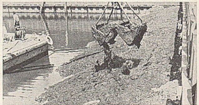
Abb. 27. Vorschüttung der Abdämmungswand mit Kleiabdeckung.
