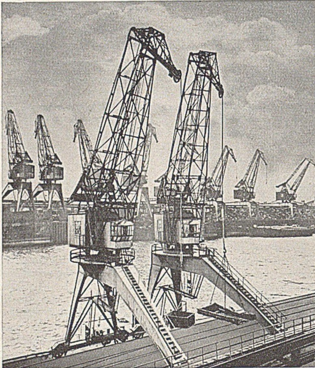
Abb. 2. Kaiwippkrane auf Halbportal mit Dreipunktlagerung. (Demag, Duisburg.)
