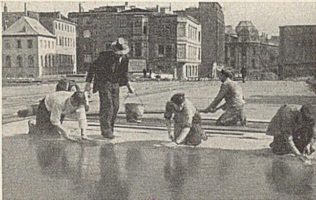
Abb. 20. Über die Oppanolfolie wird Schutzasphalt aufgebracht.
