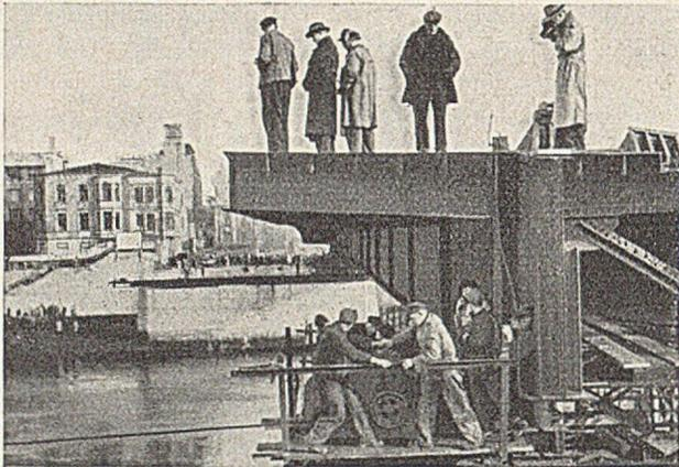
Abb. 16. Die erste Überbauhälfte wird am 18. November 1951 seitlich verschoben.
