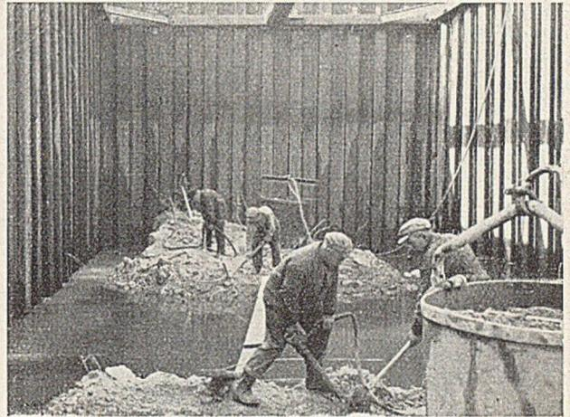
Abb. 6. Der alte Senkkastenbe'on in der Pfeilerbaugrube wird abgebrochen. Der vom Turmkran beförderte Kübel diente auch zum Betonieren.
