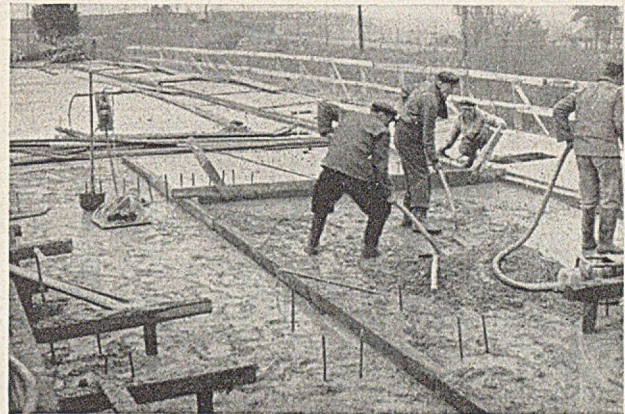
Abb. 18. Herstellen der Betonoberfläche
