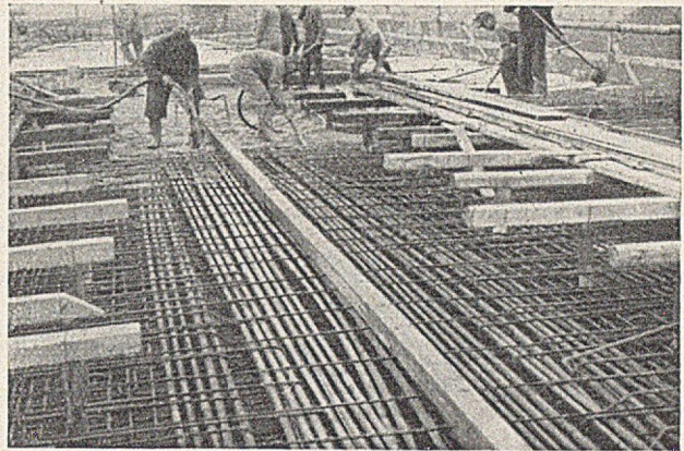
Abb. 17. Einbringen und Verdichten des Betons.
