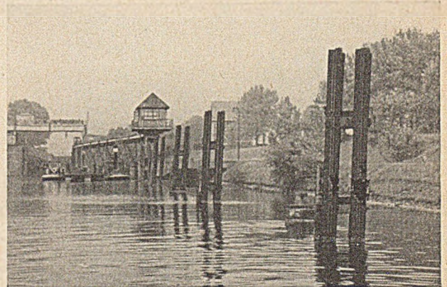
Abb. 10. Einfahrt zu einer Schleuse mit angefahrenen und verdrehten 4pfähligem Dalben.
