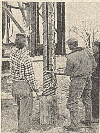
Abb. 2. Der gespreizte Dorn holt den Pfahlmantel aus dem Montageloch.
