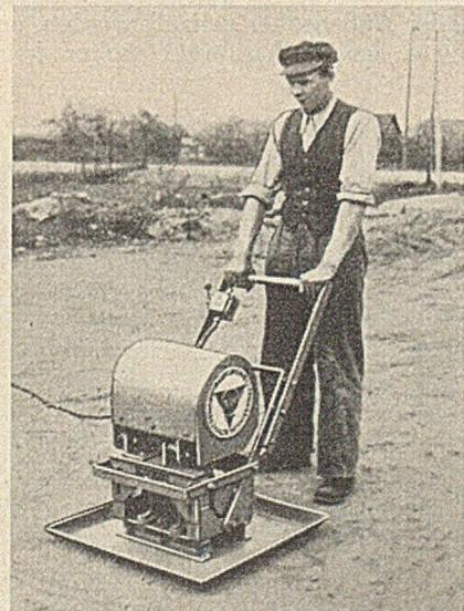
Abb. 20 a. ABG-Oberflächen-Vibrator,  $600 \times 600$  mm, 23 PS, 55 Hz, 150 kg.
