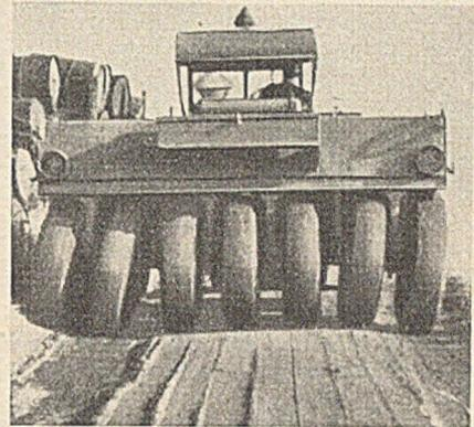
Abb. 19 a. Anhänger-Gummiradwalze, Fabrikat Scheid, 2—9 t.
