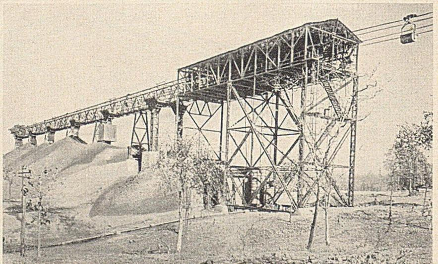
Abb. 5. Zweiseilbahn und Seilhängebahn über dem 20 000 t-Lager.
