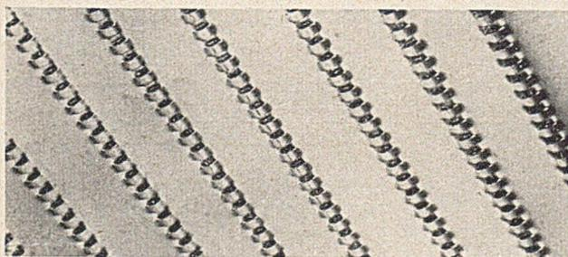
Abb. 5. Putzträger aus perforiertem expandiertem Aluminiumblech, auf das im maschinellen Spritzverfahren eine 10 cm starke Schaumbetonwand (Perlit) aufgespritzt wird.
