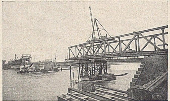
Abb. 10. Arbeiten am Pfeiler II; rechts SKR-Konstruktion im Vorbau über dem Hilfsjoch.
