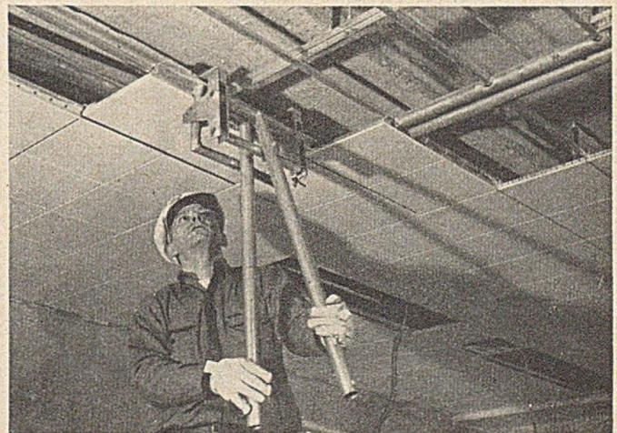
Abb. 12. Perforierte Aluminiumplatten werden mit Spezial-Werkzeugen an  $1/2''$ -Rohren angebracht.
