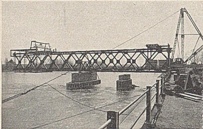
Abb. 7. WS-Konstruktion im Freivorbau.
