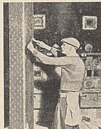
Abb. 4. Der vereinfachte Feuerschutz für Säulen beginnt mit dem Anbringen des als Mörtelträger dienenden Drahtgewebes.
