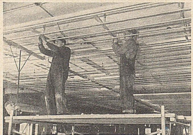
Abb. 10. Werkleute sind damit beschäftigt, Aluminiumrohre an die Hauptdecke mittels Spannschrauben zu hängen.
