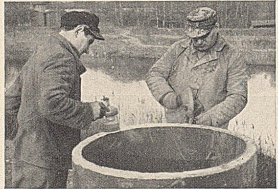
Abb. 7. Abschleifen der Tonrohre vor dem Einbau in das Dükerrohr.
