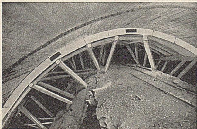
Abb. 6. Kavernenausbruch nach Ringspaltverfahren.
