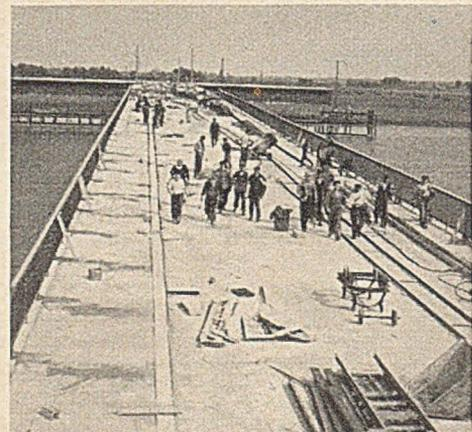
Abb. 19. Fahrbahntafel nach dem Ausschalen.
