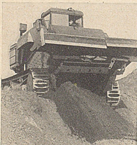
Menck & Hambrock-Schürfkübelraupe SR 53, 6,5 m³ Kübelinhalt — 150 PS-Dieselmotor — Gewicht 19 t.
