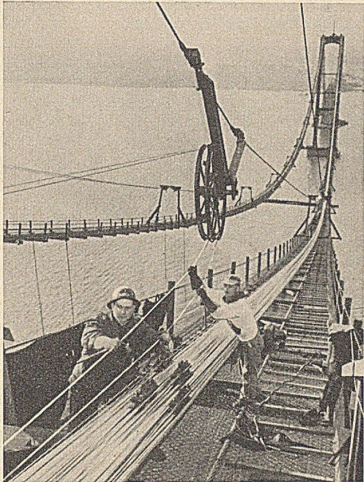
Abb. 8. Die Mannschaft empfängt die Drähte von dem Spinnrad und bringt sie in die richtige Lage.
