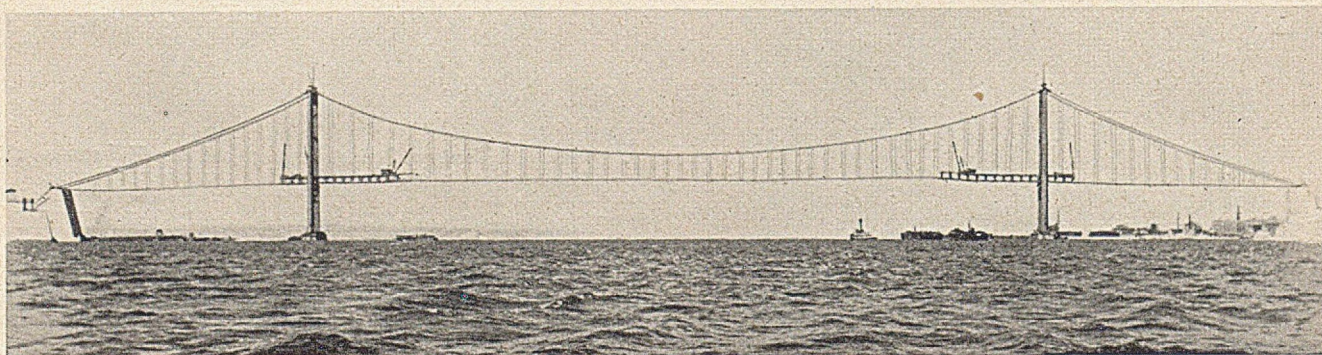
Abb. 15. Die 4 Lauf-Derricks für den Bau des Versteifungsträgers sind in Tätigkeit.
