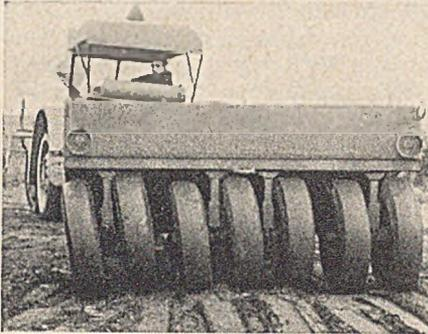
Abb. 10. Rückansicht einer Gummiradwalze beim Verdichten.
