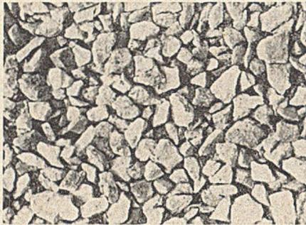
Abb. 7. Durch eine Gürtelradwalze verdichtete Schotterlage.
