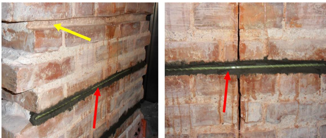
Fot. 5.2.2-2. Sposób wzmocnienia muru prętami kompozytowymi na zaprawie naprawczej Photos 5.2.2-2. Method of strengthening the wall with composite rods on repair mortar
