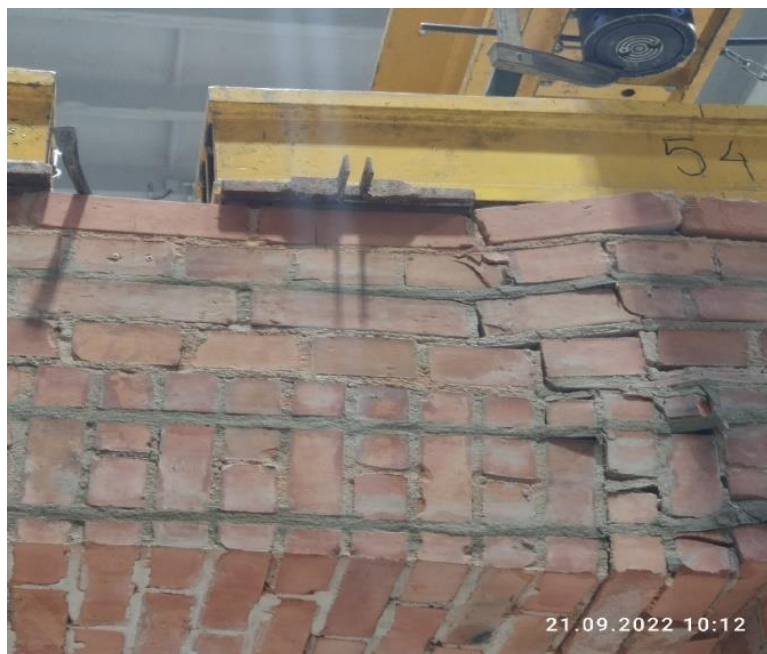
Fot. 8.4.3-5. Widok fragmentu łuku nadproża elementu badawczego C.2-1 w trakcie badania Photos 8.4.3-5. View of a fragment of the lintel arch of test element C.2-1 during the test
