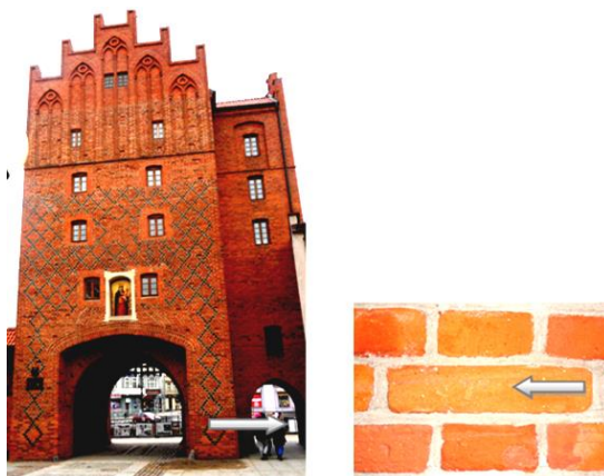
Fot. 3.1-5. Wysoka Brama z XIV w. w Olsztynie i cegła 280x135x70 w licu muru
