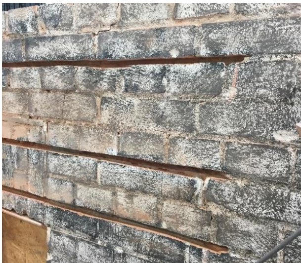
Fot. 8.4.2-3. Widok bruzd przygotowanych do nałożenia zaprawy naprawczej Photo. 8.4.2-3. View of the grooves prepared for applying repair mortar
