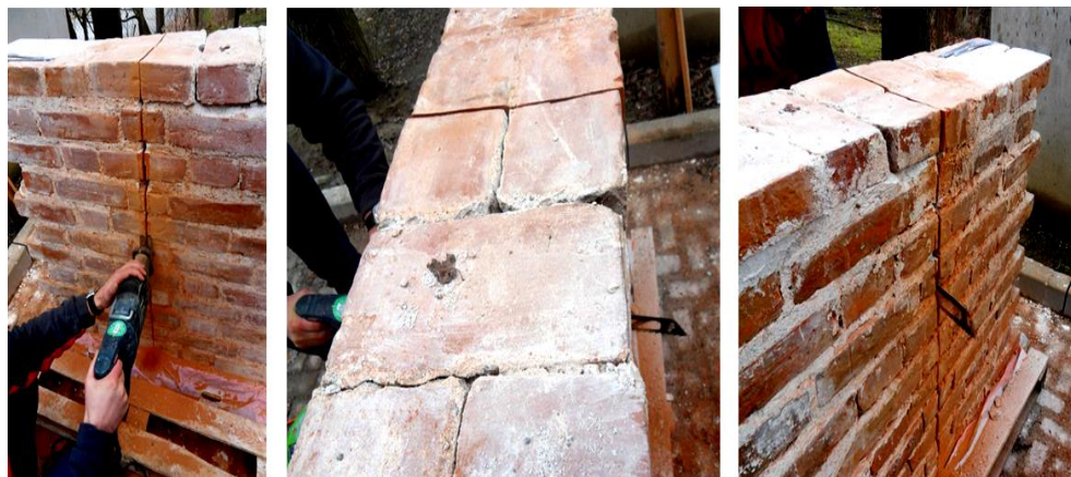
Fot. 5.2.2-1. Sposób przecięcia muru Photos 5.2.2-1. The way to cut the wall
