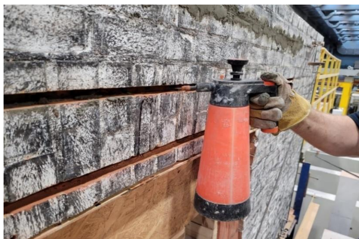
Fot. 8.4.2-2. Przygotowanie bruzd do nałożenia zaprawy naprawczej
