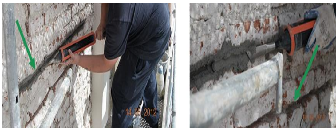
Fot. 3.4-1. Naprawa pęknięć prętami spiralnymi ściany klasztoru w Świętej Lipce [W 4 i 5]
