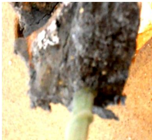
Fot. 5.2.3-12. Widok pręta GFRP z przylegającą do niego zaprawą naprawczą [38] Photos 5.2.3-12. View of a GFRP rod with repair mortar adhering to it [38]
