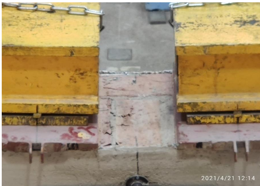
Fot. 8.4.3-2. Widok zmiżdżonych cegieł w łukowym nadprożu Photo. 8.4.3-2. View of crushed bricks in the arched lintel
