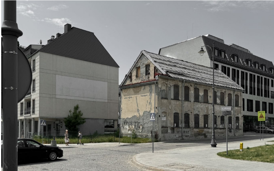
Rys. 11. Widok od strony skrzyżowania ulic Fig. 11. View from the street intersection Źródło: archiwum autora, Maj 2024.
