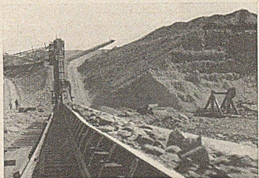
Abb. 3. Von diesem Vorbrecher wird das Baggergut mittels Förderbands weiter transportiert.
