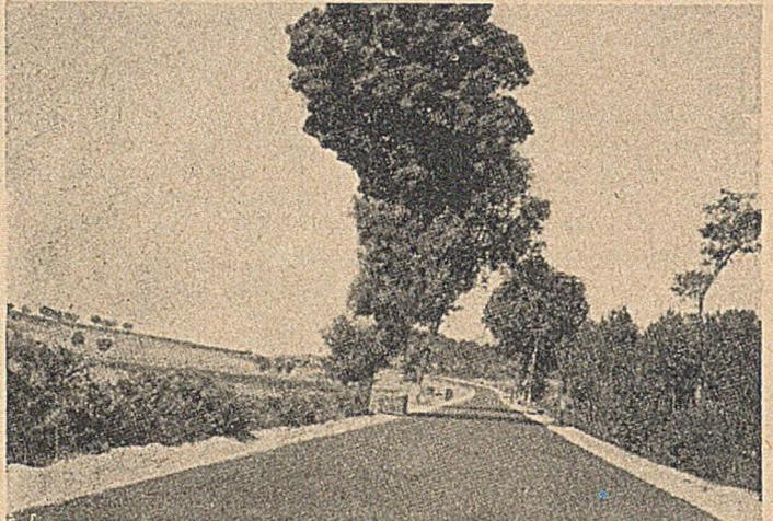
Abb. 2. Nationalstraße Nr. 17. Asphaltbetondecke von 4 cm Stärke, Zuschlagstoff Granit, hergestellt durch Fertiger „Adnum“.
