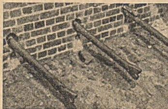
Abb. 7. Abgerissene untere Anker, 2 1/2" Ø, an der alten Mauer.
