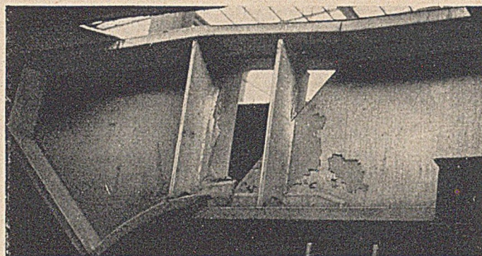
Bild 7. Instandsetzung eines geschweißten Rahmens des Bahnsteigtunnels in Duisburg Hbf. Bild der Zerstörungen an einer Rahmenecke.
