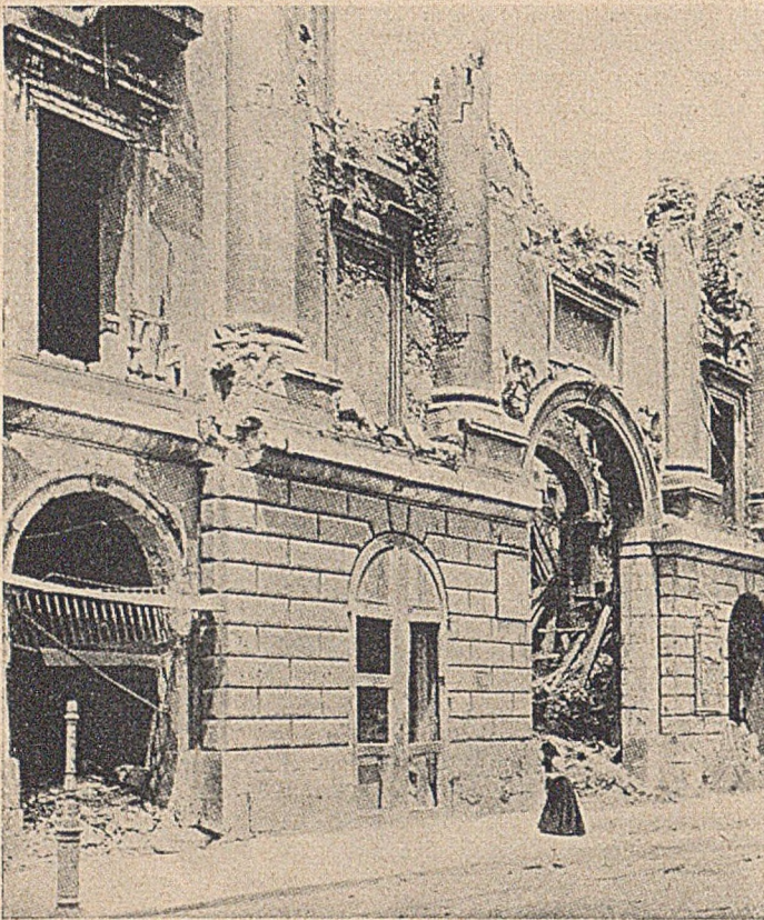
Abb. 1. Erdbebenschäden bei massiven Gebäuden in Messina 1908.
