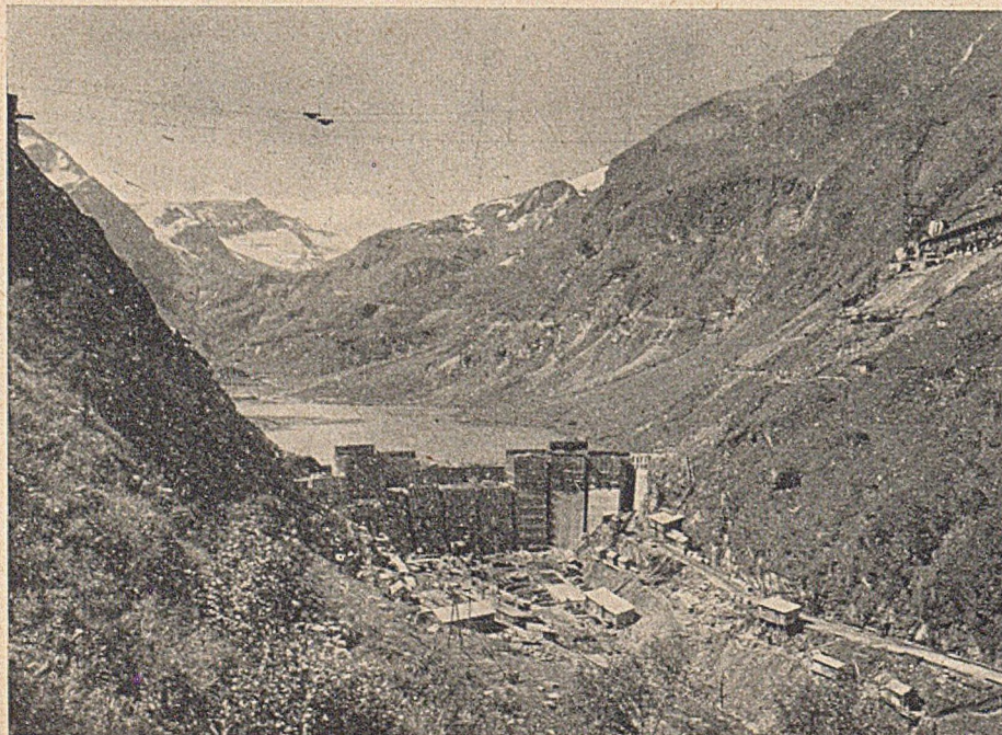
Abb. 4. Limbergsperre im Bau.
