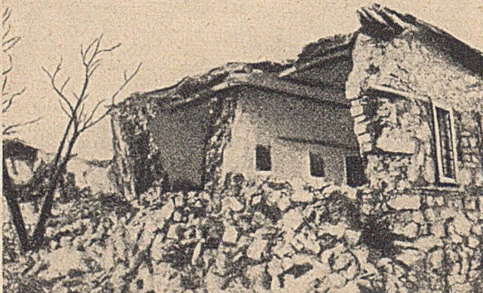
Abb. 2. Teilweiser Einsturz eines Hauses aus Lehm und Feldsteinen mit schwerem Erddach beim Erdbeben in Anatolien 1939. Das Dach hat die Bewohner der vorderen Zimmer erschlagen.
