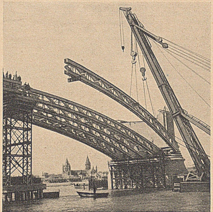
Bild 3. Absetzen eines halben Bogens auf Widerlager und Stützjoch der Straßenbrücke über den Rhein bei Mainz.
