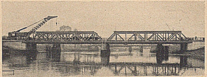
Bild 17. Lesumbrücke bei Bremen-Burg, km 133,3, Bremen—Bremerhaven, nach der Wiederherstellung aller vier Überbauten.
