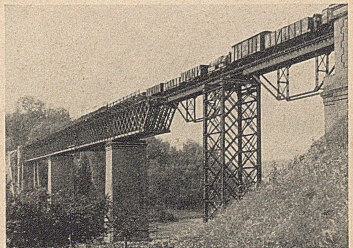
Bild 34. Viadukt über das Kochertal bei Schwäbisch-Hall, Strecke Crailsheim—Heilbronn. Behelfsmäßige eingleisige Wiederherstellung.
