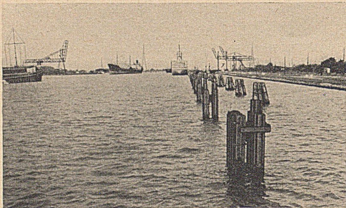
Bild 5. Neue Stahldalben im Binnenhafen von Brunshüttelkoog.
