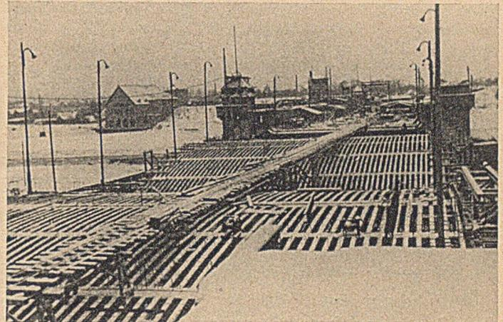
Bild 22. Fertige Bogenroste beider Strombögen. Winter 1947/48.
