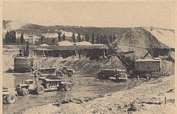
Bild 6. Elsaß-Kanal, Löffelbagger mit Euclid-Bodenentleerern (Aufnahme 30. 5. 1950).
