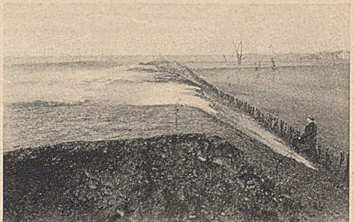
Bild 5. Grubenberge, die längs eines Emscherdeiches in Brand geraten sind.
