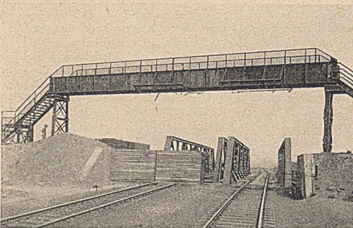
Bild 14. Dammbalkenverschluss an der Kleinen Emscher in Duisburg-Hamborn für eine zweigleisige Zechenbahn. Eine Hälfte ist probeweise geschlossen.
