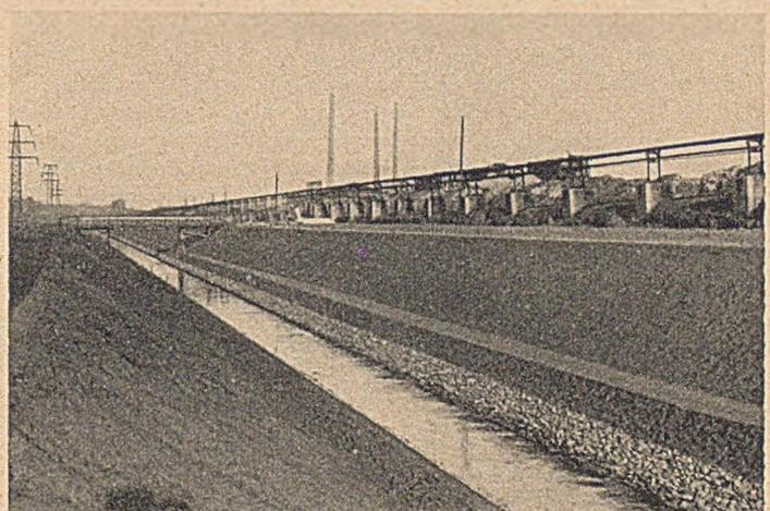
Bild 10. Wie Bild 9. Die Deiche sind erhöht, das Flußbett eingengt und die Sohle gehoben worden. Zustand 1948.
