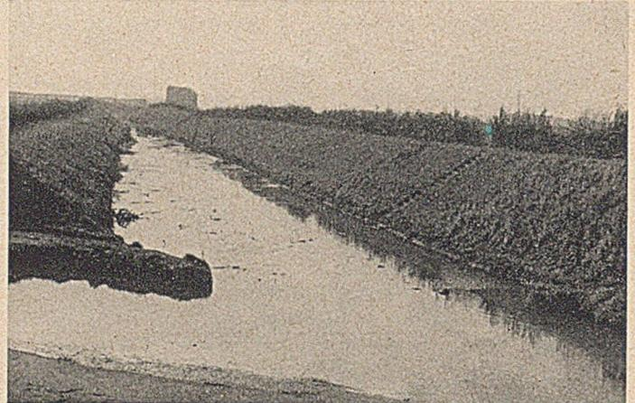
Bild 2. Mündung des Zollvereinsgrabens im Jahre 1948. Infolge Bergbaues ist das Gelände abgesunken. Der Bach ufert aus.
