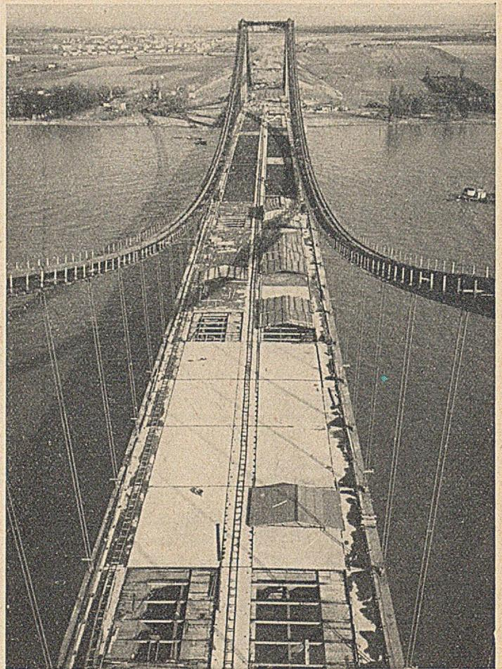
Abb. 204. Blick vom Pylon auf die Fahrbahn während des Betonierens der Fahrbahnplatte.
