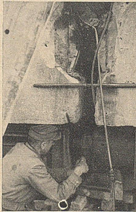
Bild 9. Die Stirnseite des Bogens mit teilweise geöffneter Scheitelgelenkfuge und die Bedienung des Stellrings der äußersten Presse unter dem Bogen.
