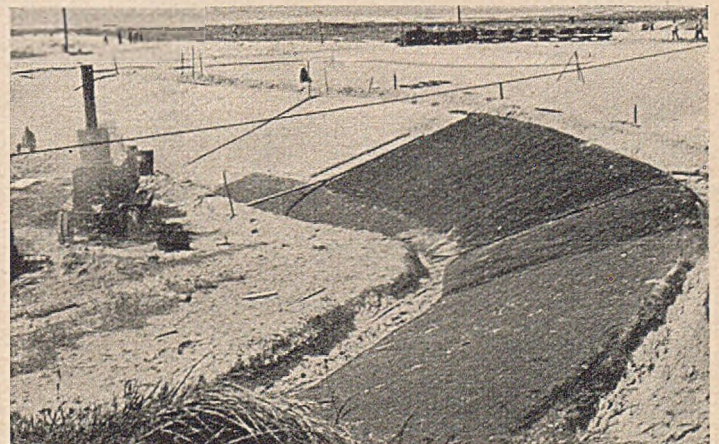
Bild 3. Oberflächenbehandlung der Buhne.
