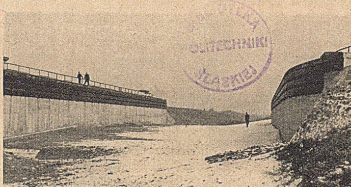
Bild 16. Kanalüberführung Stever am Dortmund-Ems-Kanal.
