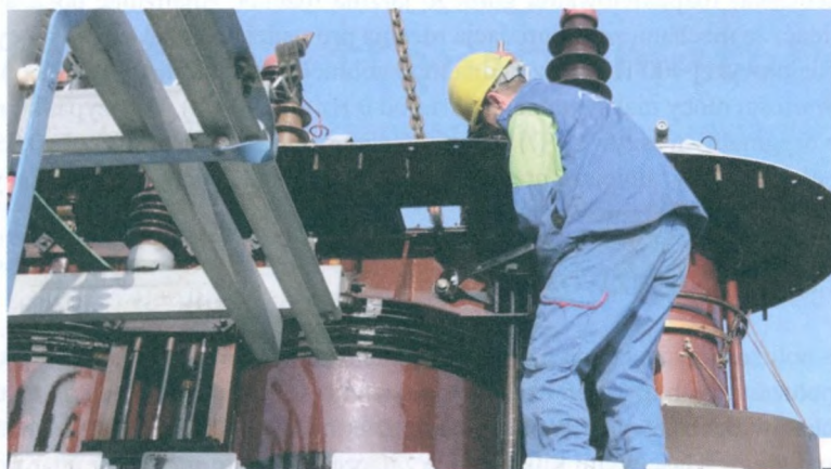
Rys. 2. Luzowanie prasowania rdzenia transformatora
