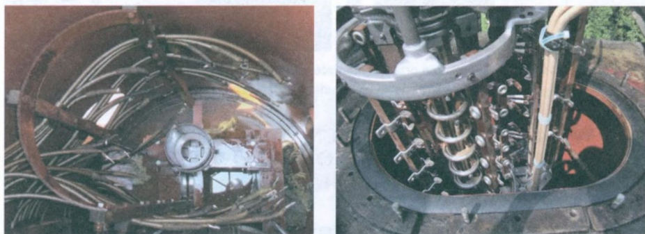
Rys.2. Widok przedziału PPZ w kadzi transformatora po demontażu RS4 (z lewej) oraz instalacja przełącznika MS (z prawej)
