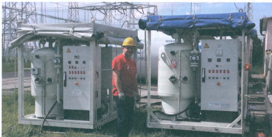
Rys. 13. Agregaty MAS 6000 w trakcie nagrzewania transformatora
