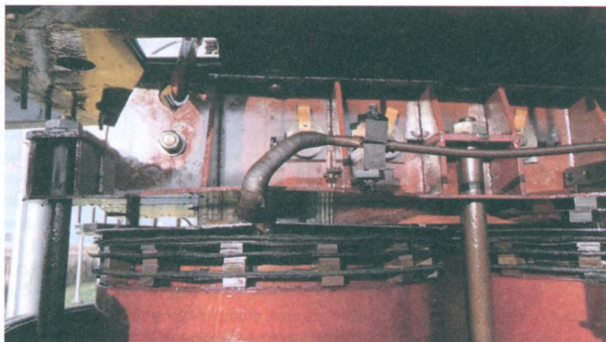
Rys. 4. Uzwojenie transformatora pozbawione elementów dociskowych
