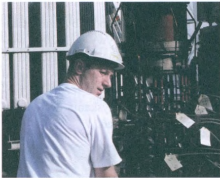
Rys.4. Oznaczanie połączeń przed demontażem PPZ PO (z lewej) oraz nowy przelącznik V III 200 Y w trakcie wykonywania nowych połączeń (z prawej)
