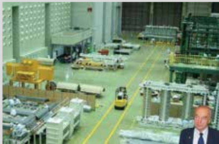
Klinicznie czysta hala montażu transformatorów.
