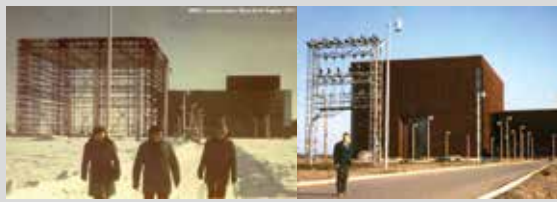
Hala Wysokich Napięć w budowie – zima 1971, a po roku już czynne Laboratorium WN.
