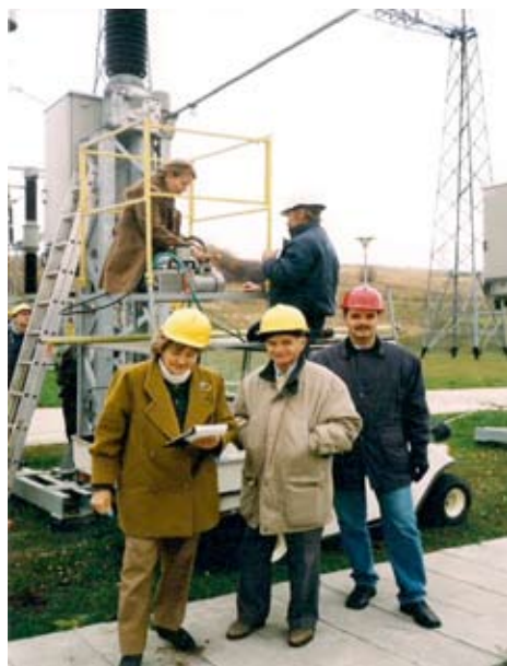
Rys. 17. Prace inżynierskie w terenie; pomiary wyłącznika na 123 KV z SF 6 na stacji WW. Na rusztowaniu – Iwona Łosiewicz, stoją: oboje z Lusią i pracownikiem stacji .
