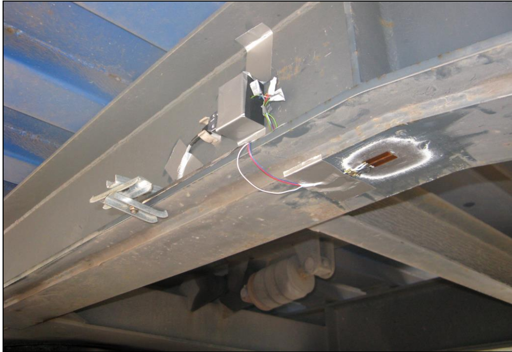
Rys. 82. Miejsce naklejenia tensometrów
