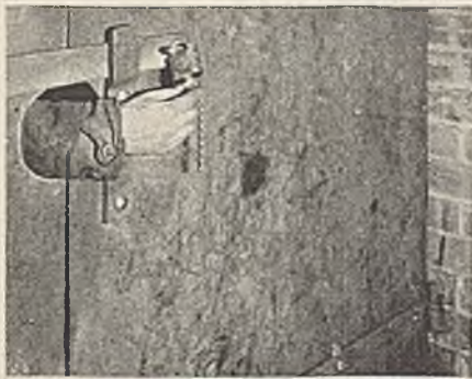
Door Padlocked on Inside
