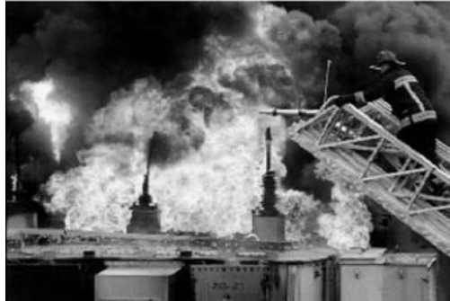
Rys. 2. Gaszenie pożaru transformatora spowodowanego eksplozją widocznych przepustów
