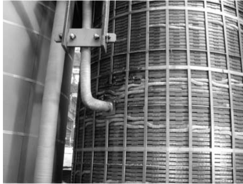
Rys. 12. Uzwojenie GN zmodernizowanego transformatora 270MVA/220kV. Jednostkę „wciśnięto” na rdzeń transformatora TW240000/110, przy zastosowaniu chłodzenia ODAF oraz zredukowaniu izolacji zwojowej i międzykanałowej.
