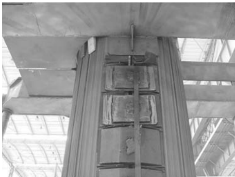
Rys. 3. Sworznie i nakładki prasujące rdzenia dwuramowego autotransformatora RTdxP125000/200
