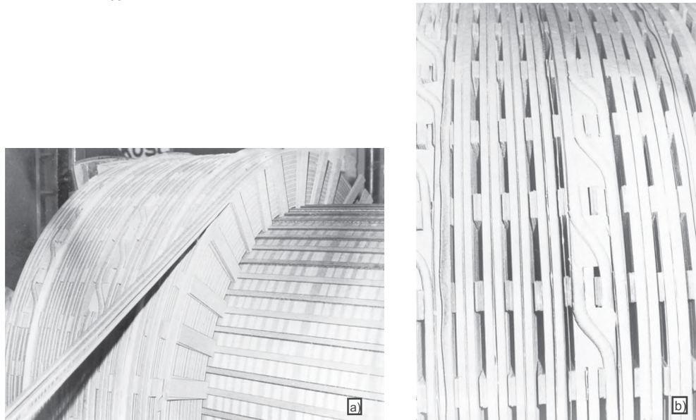
Rys. 3.18. Dwutorowe uzwojenie SN autotransformatora RTdxP125000/200 z przepleceniami napięciowymi, wykonywane 4-ma bliźniakami, a) widok podczas nawijania, b) widok przejść międzycewkowych.
