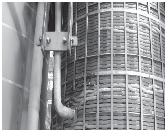
Rys. 3.12. Uzwojenie GN zmodernizowanego transformatora 270MVA/220kV. Jednostkę „wciśnięto” na rdzeń transformatora TW240000/110, przy zastosowaniu chłodzenia ODAF oraz zredukowaniu izolacji zwojowej i międzykanałowej.
