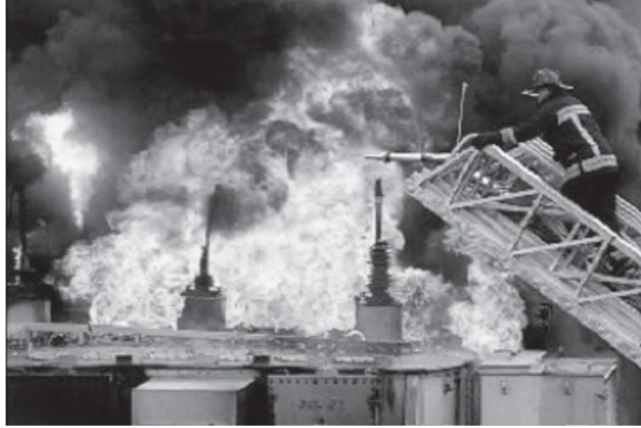
Rys. 3.29. Gaszenie pożaru transformatora spowodowanego eksplozją widocznych przepustów
