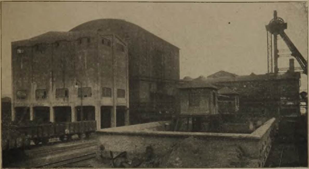
Fig. 2. Eisenbetonfeinkohlenturm und Pulsometerbassin.
