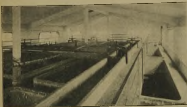
Fig. 6. Blick in das Innere des Feinkohlenturmes.
