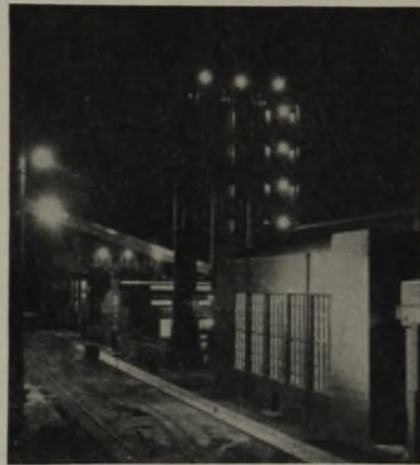
Abb. 1. Werksbeleuchtung mit Glühlampen-Scheinwerfern.
