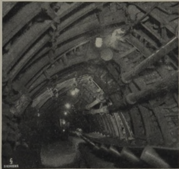
Abb. 7. Abbaustreckenbeleuchtung.
