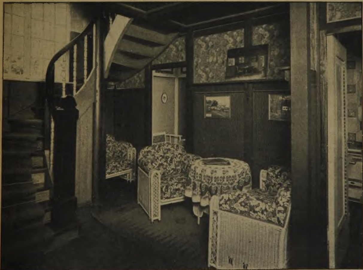
Außeres und Diele im Landhaus der Frau Dr. Platz in Wendefurth im Harz. Ausgeführt von Friedr. W. Lohmüller, Architekt in Gütten.
