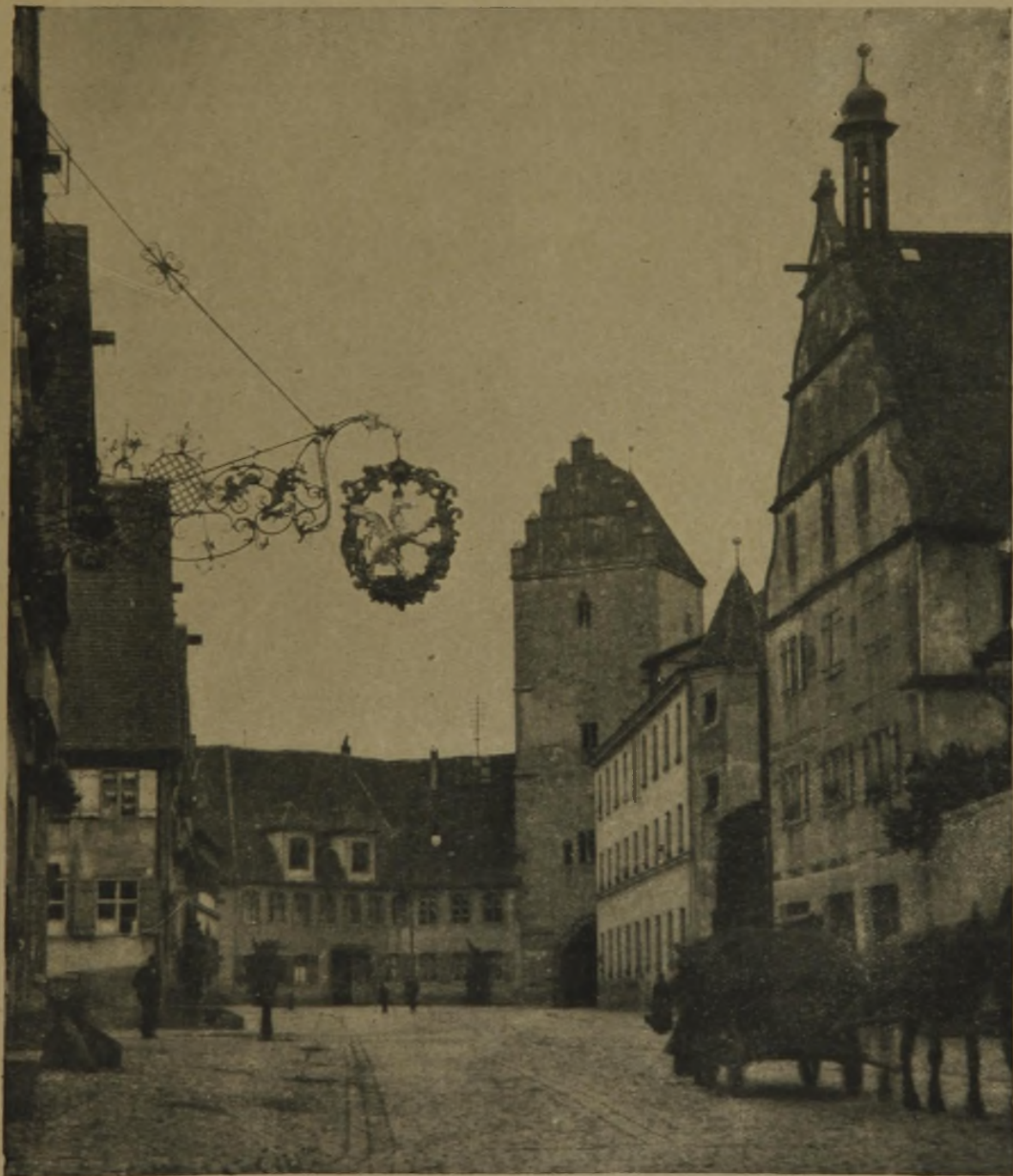
Crailsheimer Tor in Dinkelsbühl. Aus: Paul Wolf: Städtebau. Verlag von Klinkhardt & Biermann in Leipzig. 13. Juli 1921.
