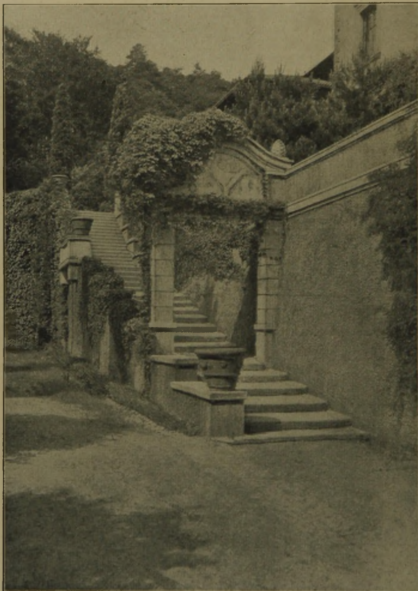
Treppe zur großen Terrasse.
