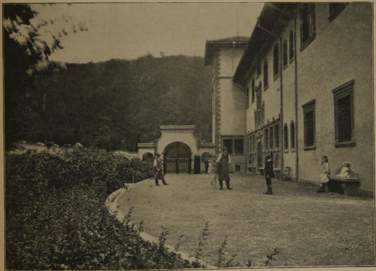
Ansicht der Nord-Fassade.
