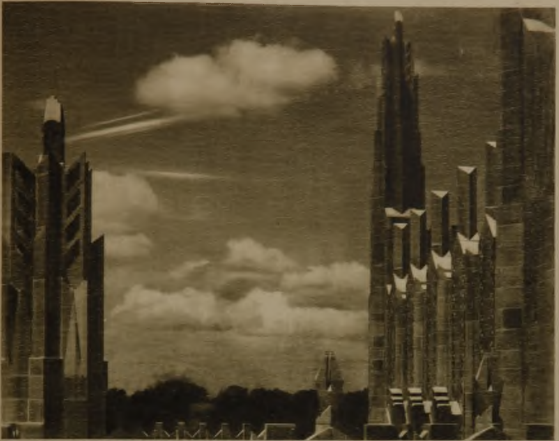
Einzelheiten vom Dach mit Scheinwerfern
