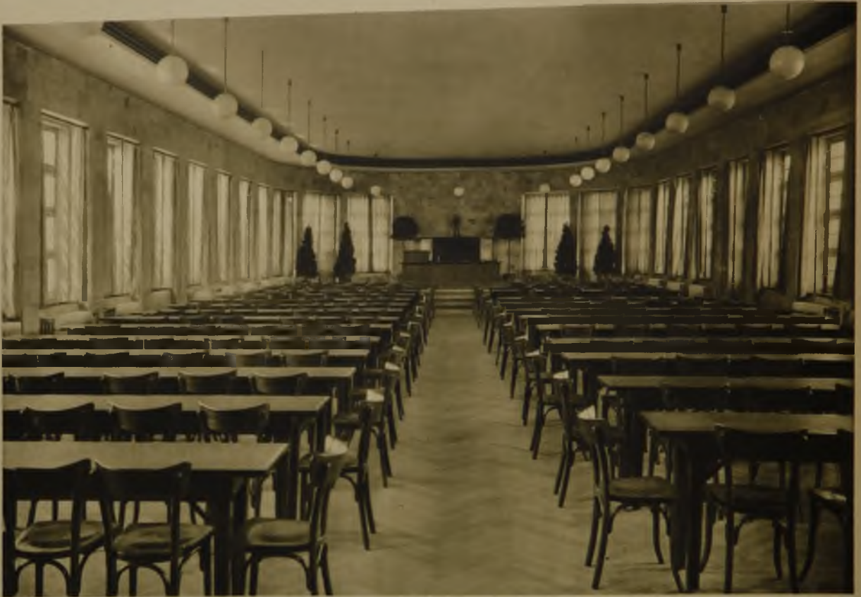
Unterrichtssaal im IV. Obergeschoß des Verwaltungsgebäudes
