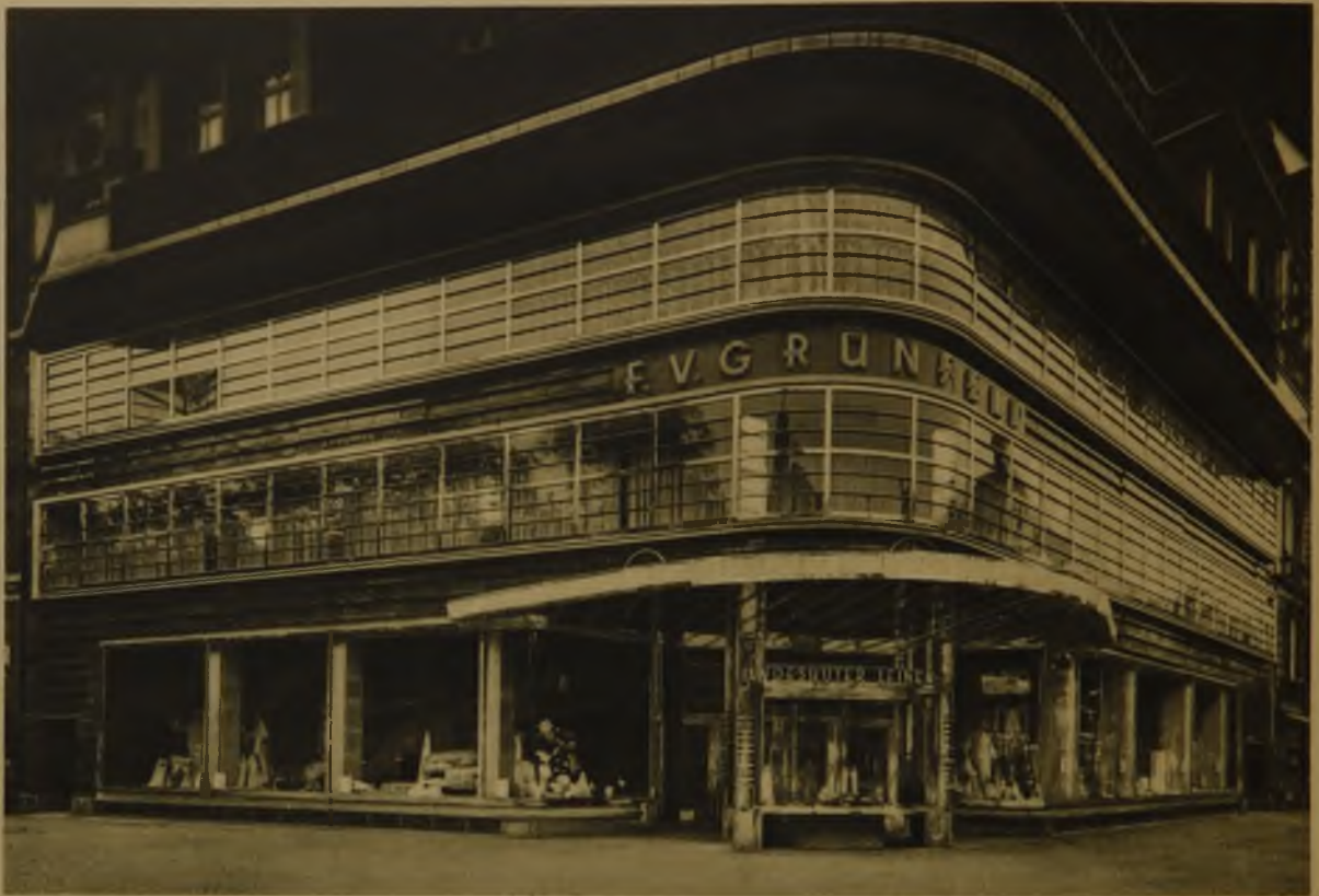
Grünfeld-Haus, Berlin, Kurfürstendamm. Architekt Dipl.-Ing. Otto Firle, Berlin Foto M. Krajewsky, Berlin (Ergänzungsbild zu unserem Aufsatz „Die moderne künstliche Beleuchtung“ vom 4. Feb. d. J., woselbst auf S. 78 irrtümlich bei diesem Bau ein anderer Architekt als Urheber angegeben war)
