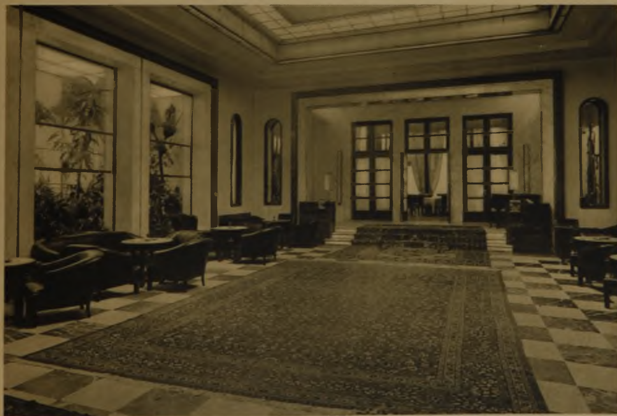
Große Halle. Blick nach Restaurant und Wintergarten
