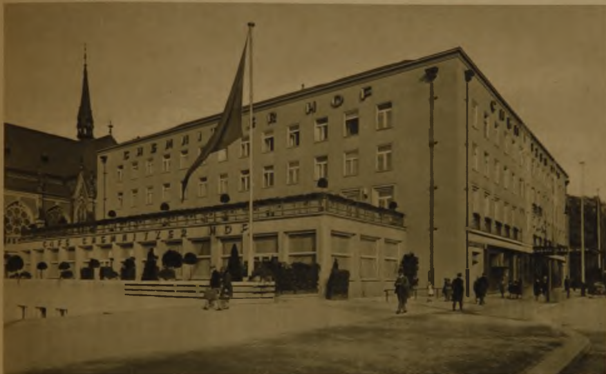
Blick von der Schillerstraße auf die Kaffeehausfront
