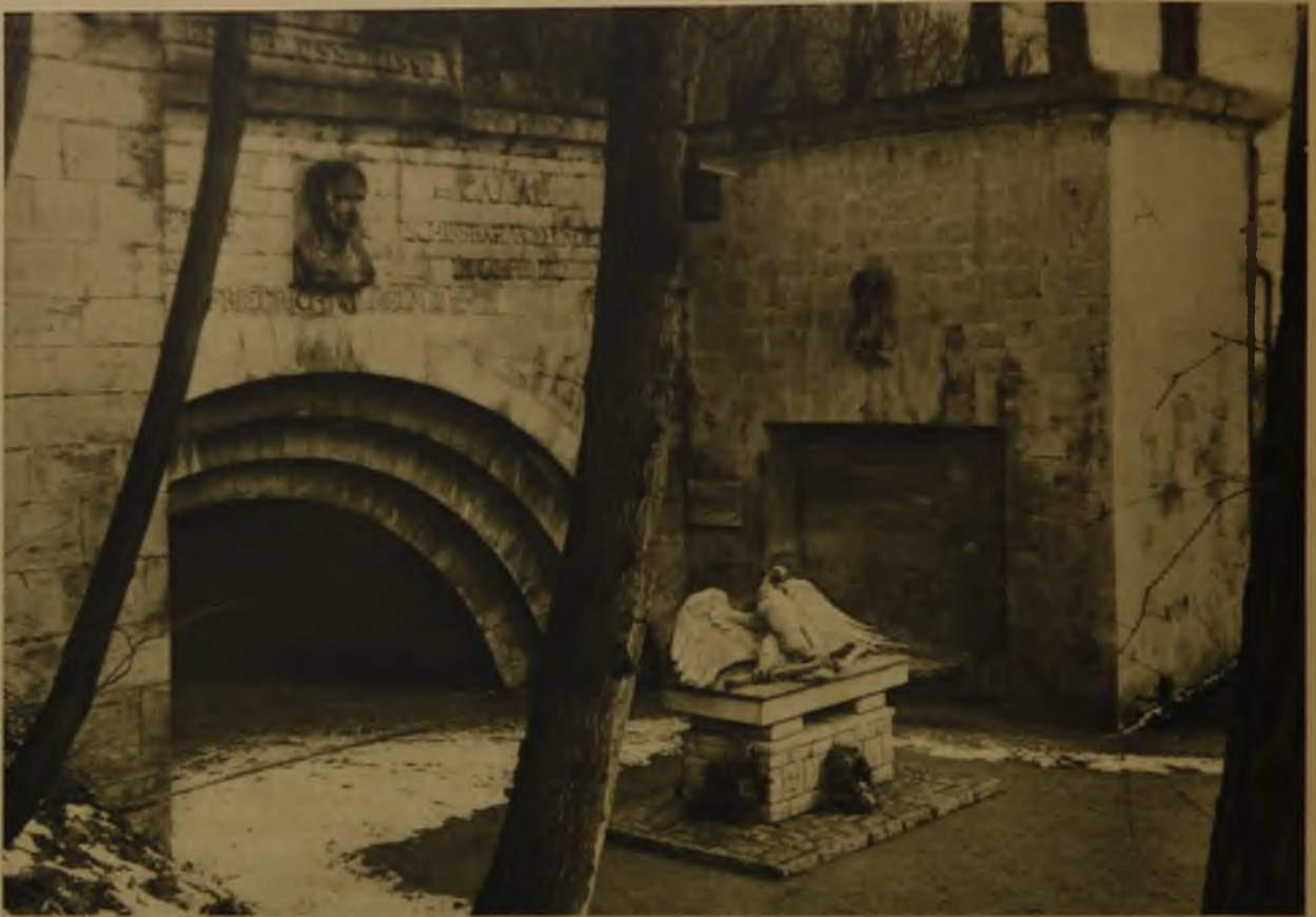
Portal des Redentunnels mit Kriegerdenkmal 1930
