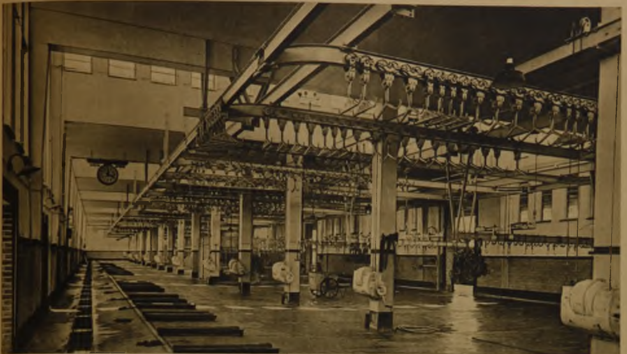
Großviehslachthalle, links Eintriebtore, überdeckte Blutrinne (Töteplatz), fahrbare Schragen, Doppelwinden an den Pfeilern
