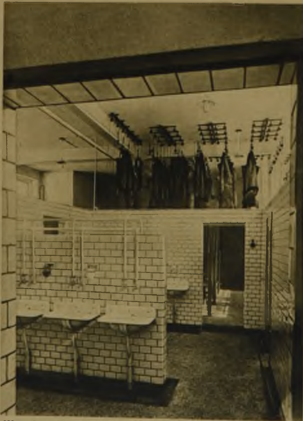
Wasch- und Umkleideräume im Verwaltungsgebäude; die Berufskleidung hängt zur Trocknung und Lüftung an der Decke
