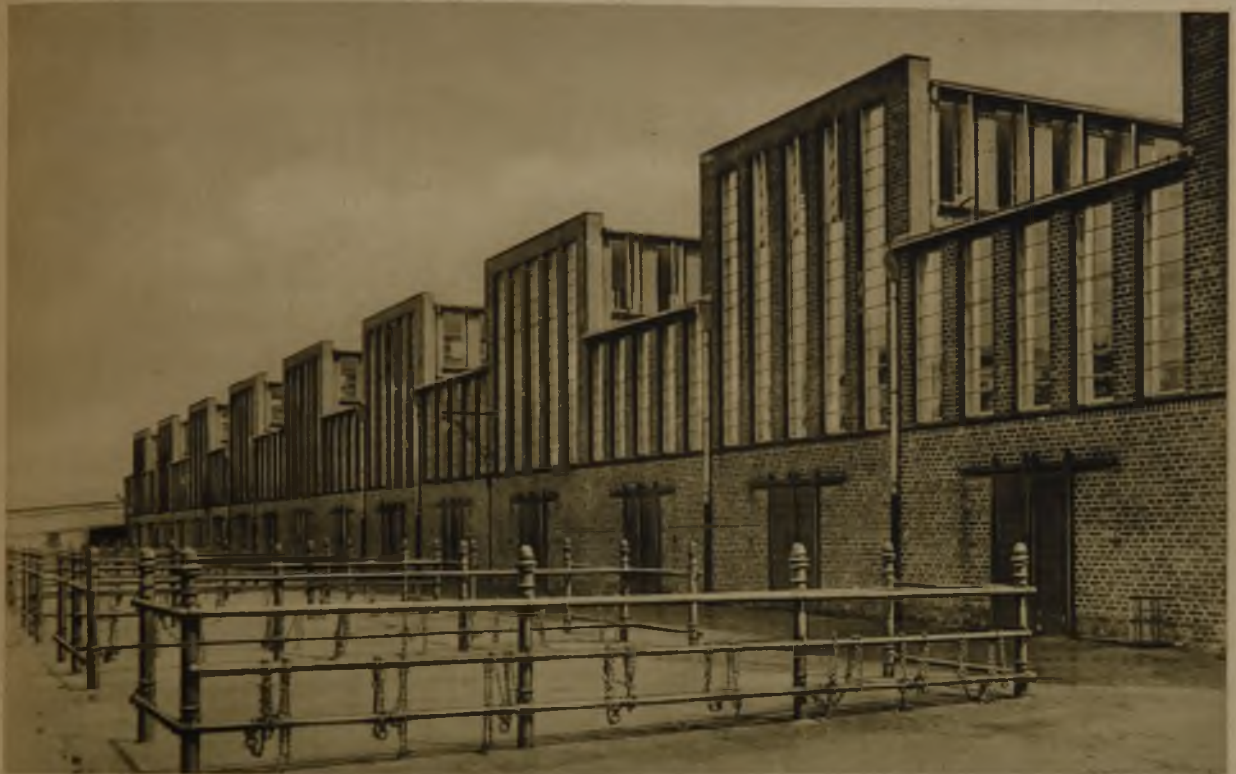
Großvieherschlachthalle (Anbindevorrichtung aus vorhandenem Material)
