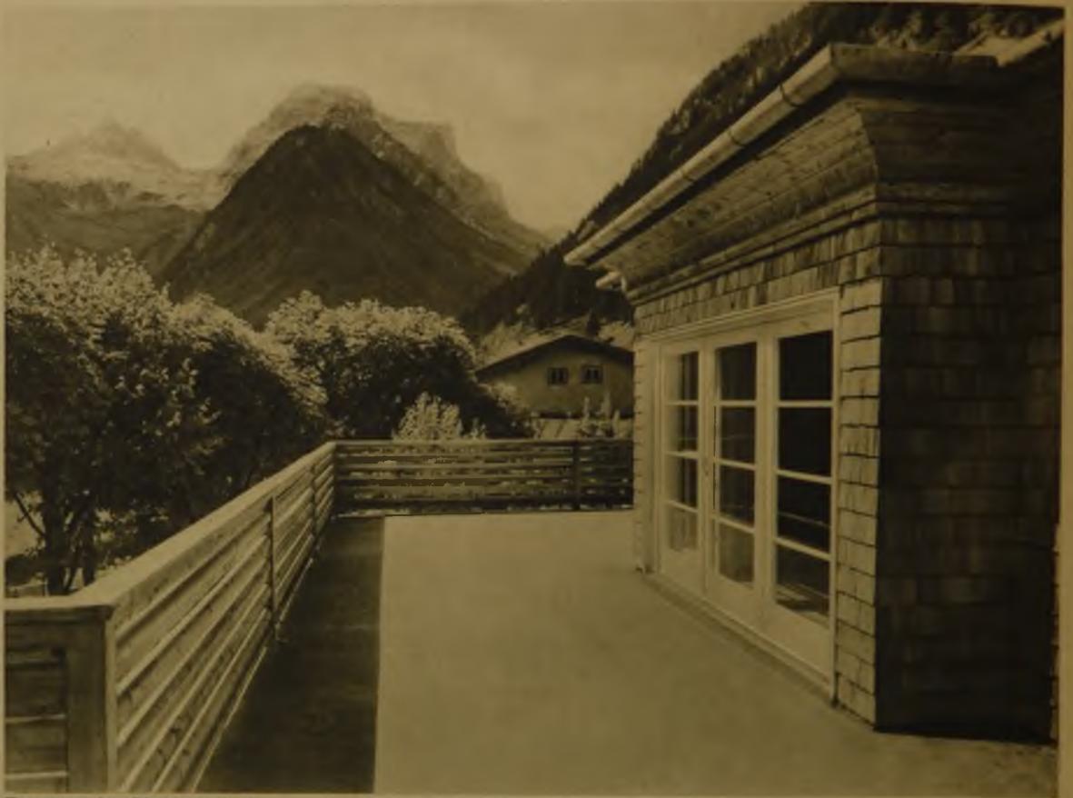
Terrasse im Obergeschoß
