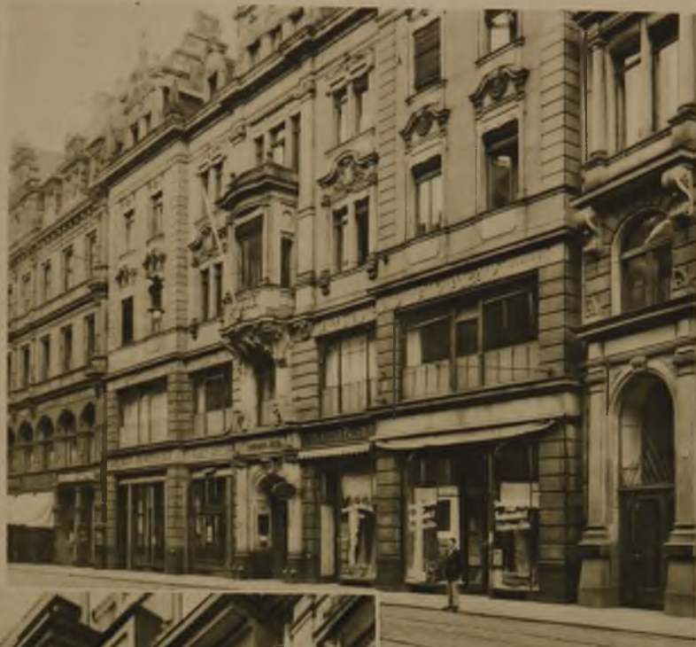
Ansicht Waisenhausstraße vor dem Umbau
