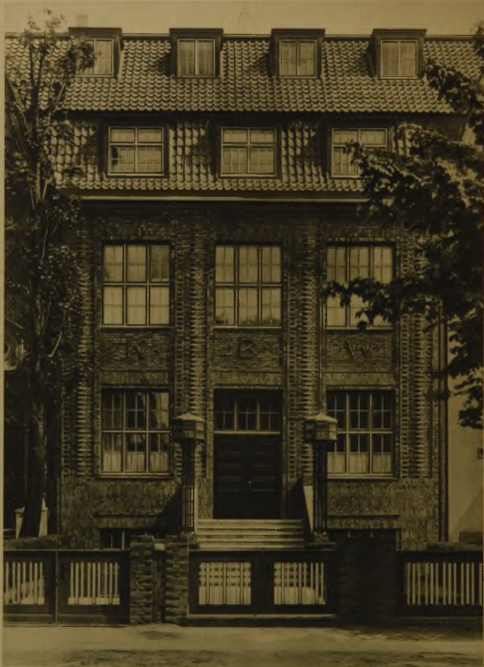
Ansicht an der Hallwigstraße
